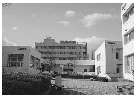
事務局・駐車場側から講義棟へ向かう 坂道。正面奥の高い建物は、共生シス テム理工学類研究実験棟
